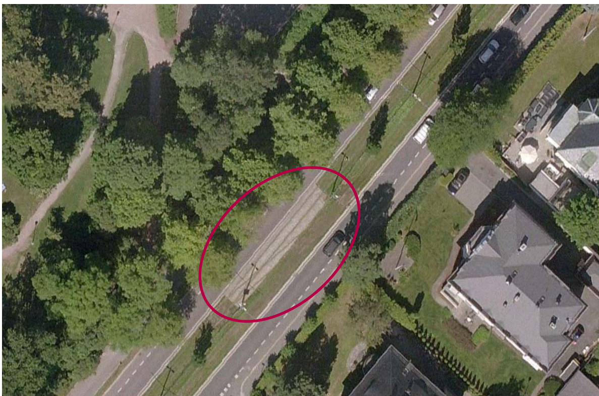
Figur 2.3 Figur 2.4 Bildet viser hvor det er opparbeidet overkjøringsspor for trikk i Kirkeveien.
